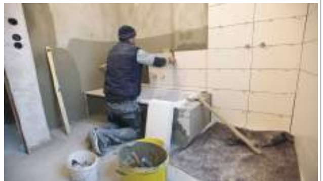
Shtrimi i pllakave dhe instalimeve hidraulike
