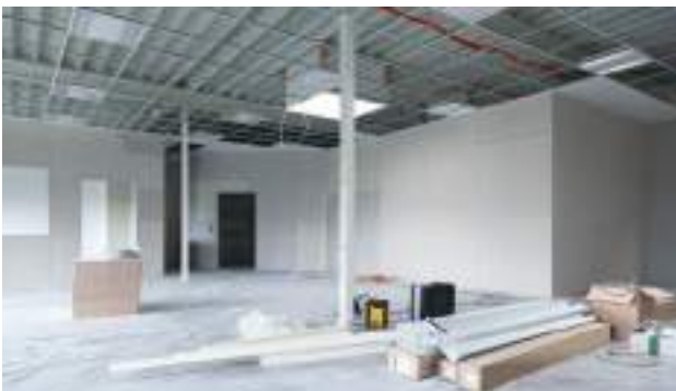
Punimet e gipsit dhe instalimet elektrike
